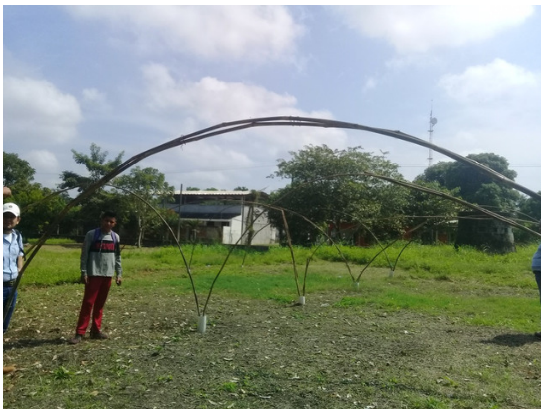
Figura 10. Construcción de Macrotúneles
